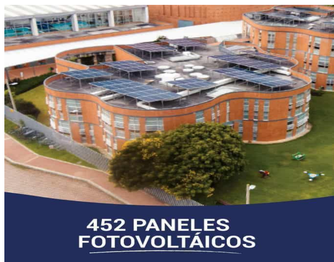
Ilustración 11 Techo Colegio Rochester
