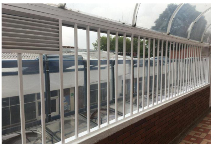
Pasillo Del Colegio Santo Tomás de Aquino, Tercer Piso
