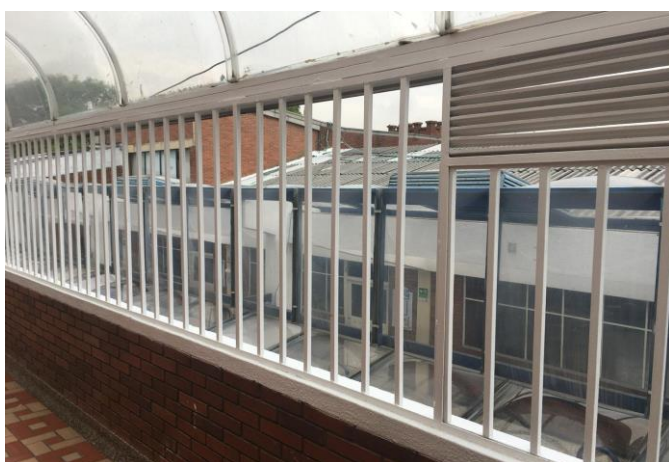
Pasillo Del Colegio Santo Tomás de Aquino, Tercer Piso
