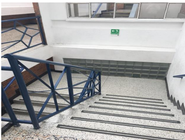
Escaleras Segundo piso Colegio Santo Tomás De Aquino
