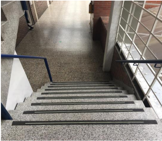
Salida de Escaleras Tercer piso Colegio Santo
